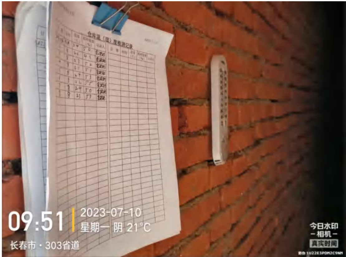
整改前：4#仓库温湿度未每日进行记录
